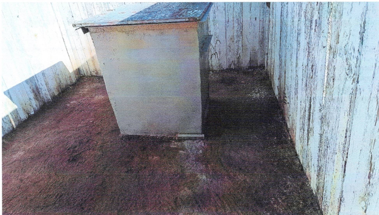
Фото - площадка с водонепроницаемым твердым покрытием
